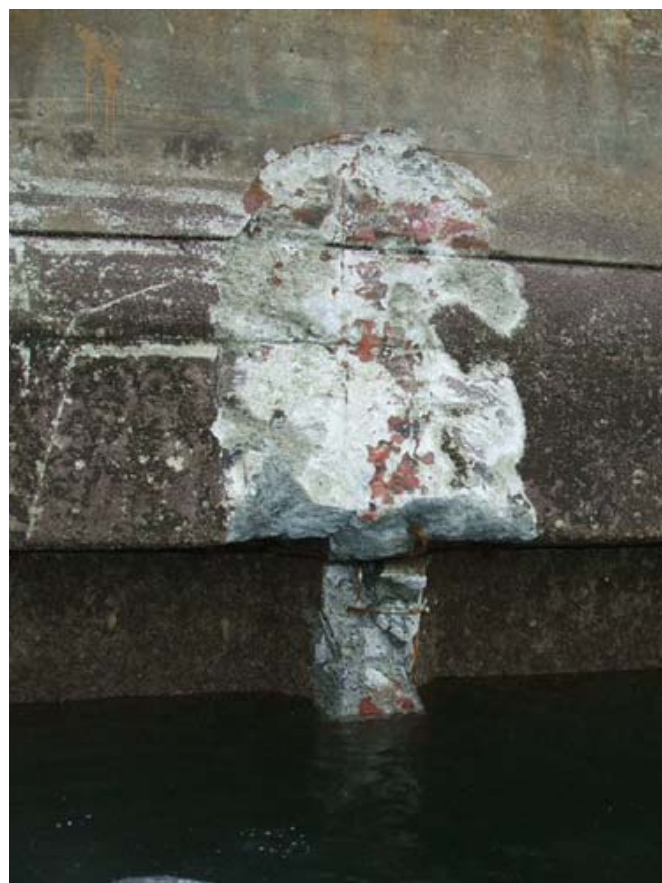
写真4 岸壁損傷部
