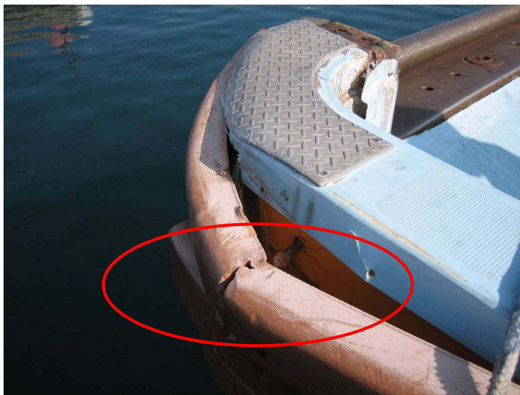
写真8 B船右舷船尾部損傷状況
