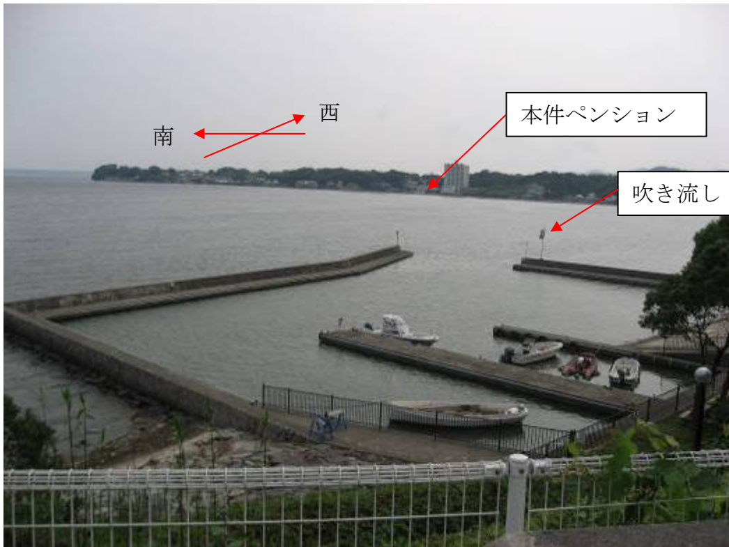
写真15 ハーバー付近の状況
