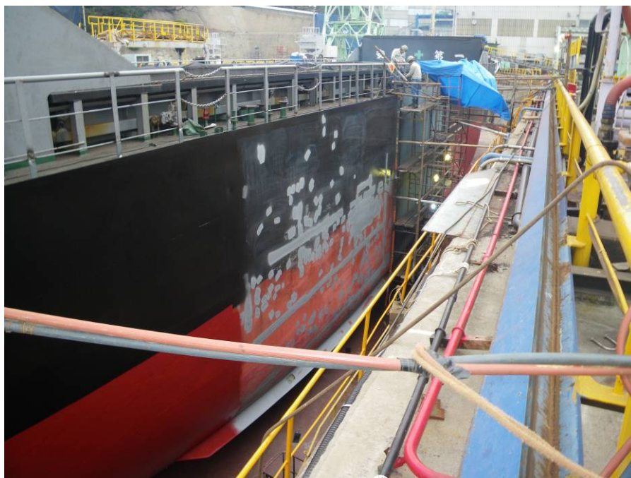
写真2 右舷外板を修理中のC船
