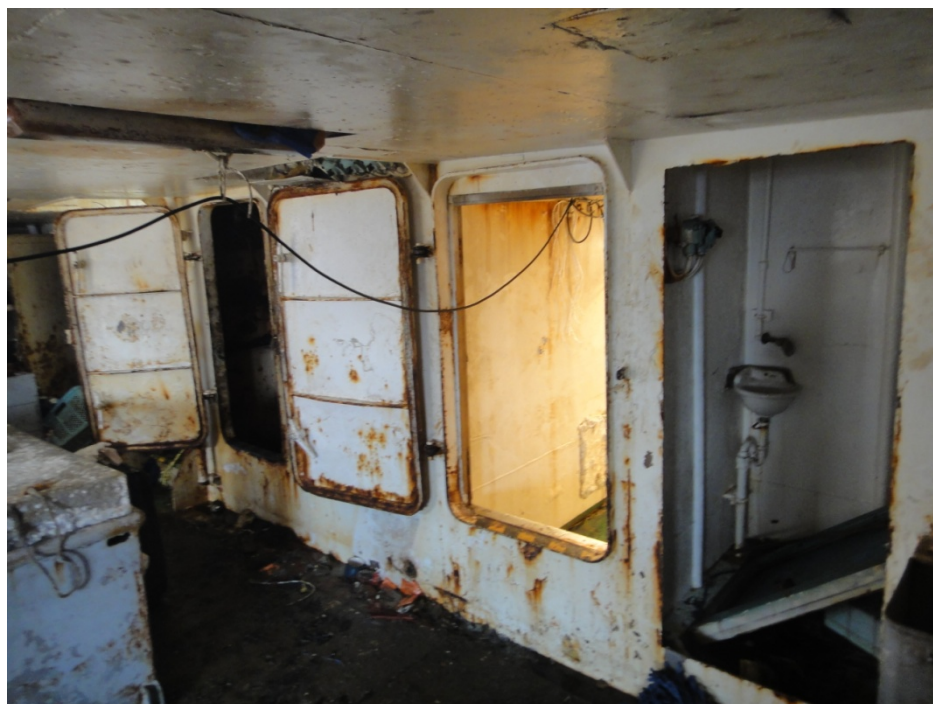
（左から、空調機室出入口、居住区出入口、トイレ（戸は脱落））
