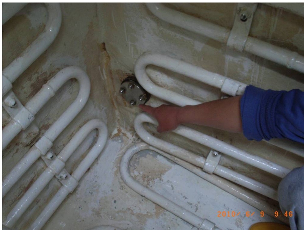
写真4 4番魚倉内の排水口
