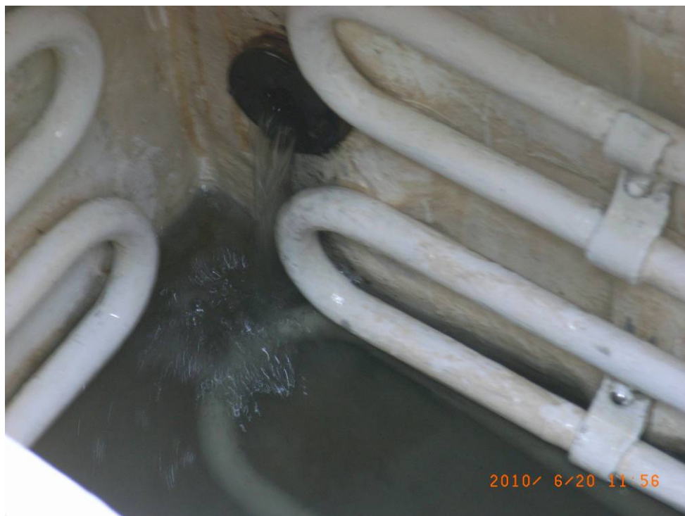
写真5 滞留水の排水状況
