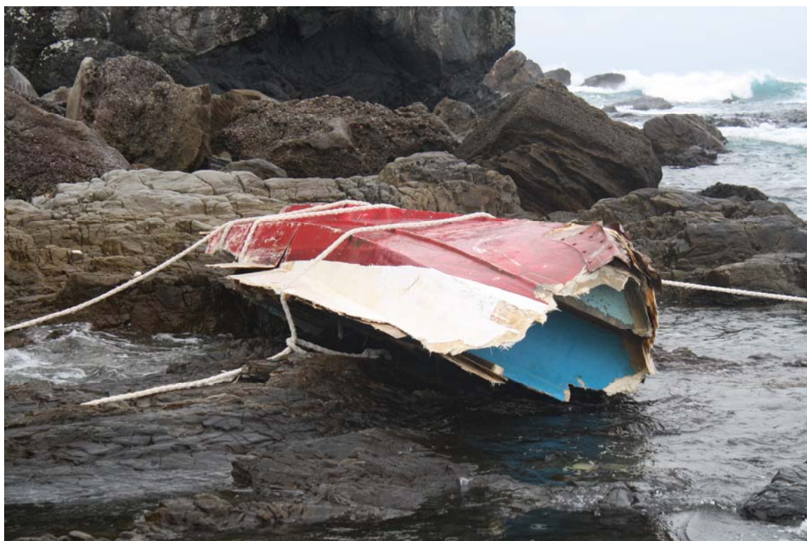
写真4 大破した本船（船体）
