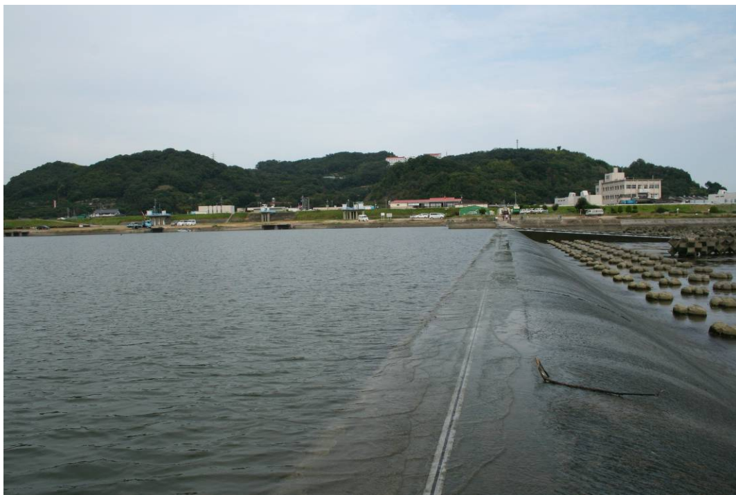
写真1 本件潮留堰の状況
