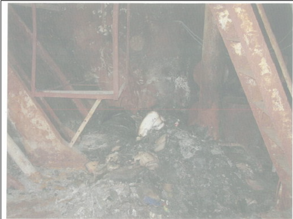
写真4 焼損した船首倉庫内部
