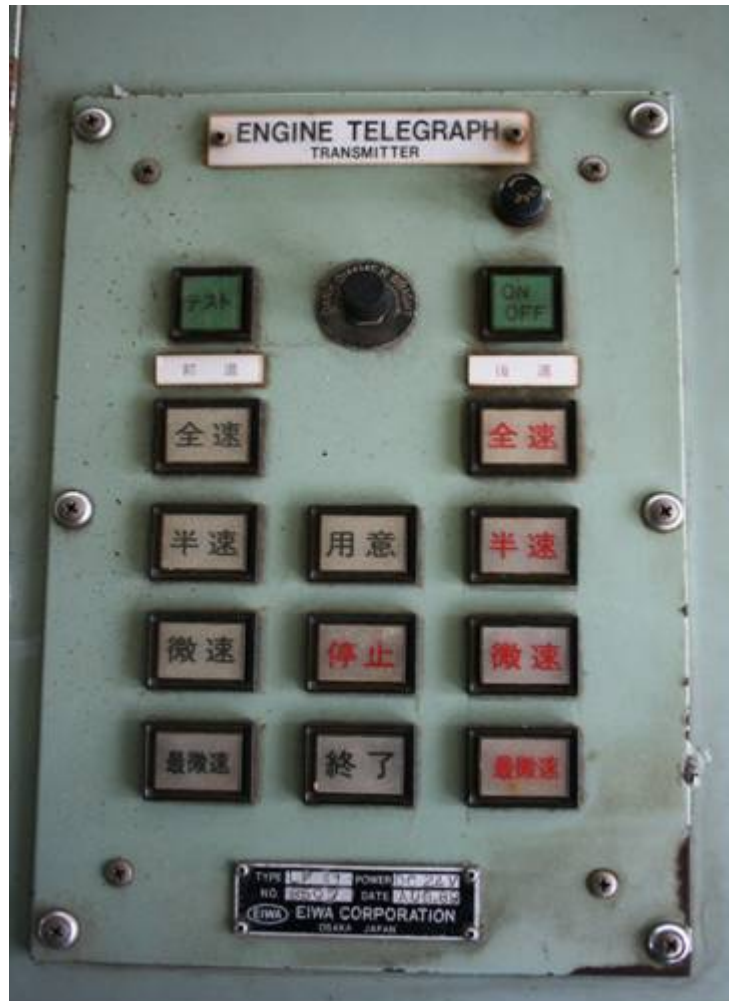
写真8 A船の機関遠隔操縦盤上面の船橋側表示灯
