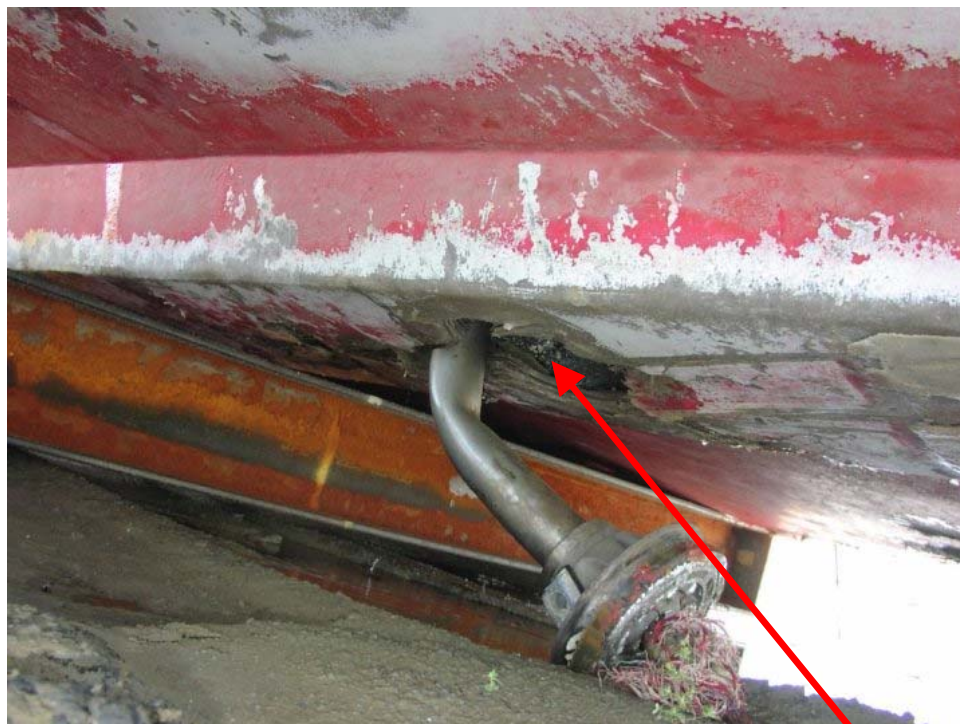
写真3 送受波器軸付近の損傷
