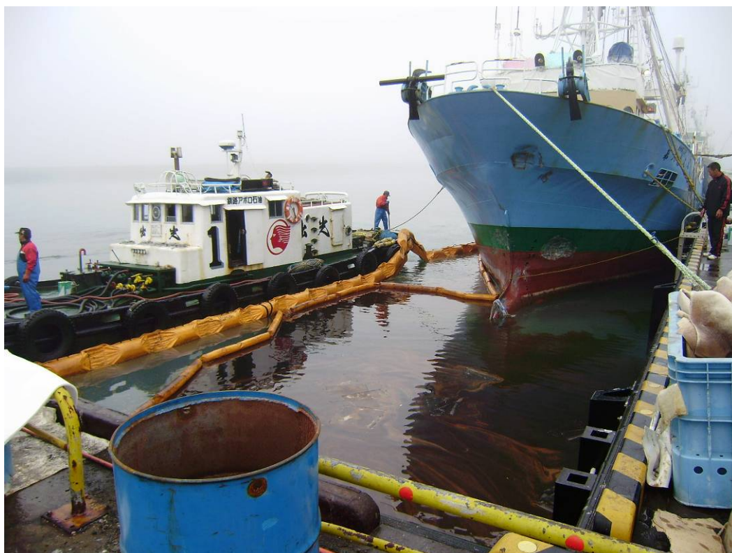
写真5 オイルフェンスの設置状況（船尾方）
