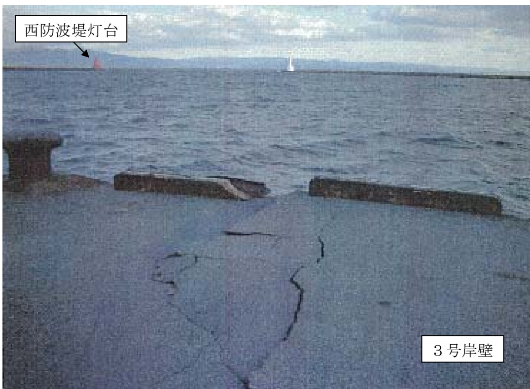
写真2 3号岸壁の状況
