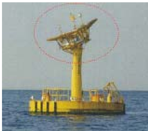
写真5 損傷した城ヶ島沖灯浮標
