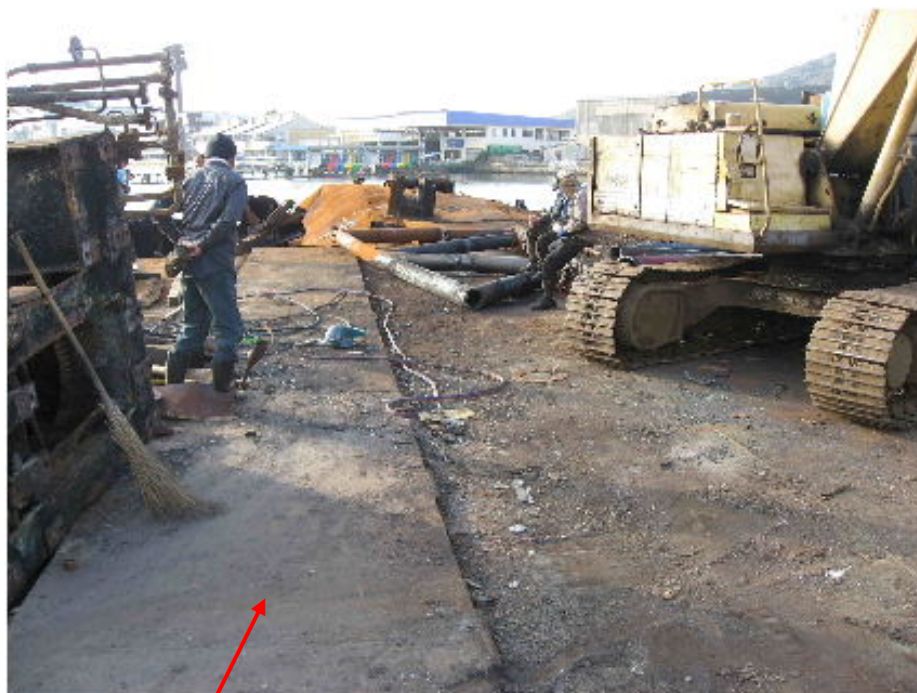
写真10 クレーン車走行用鉄板通路の状況①
