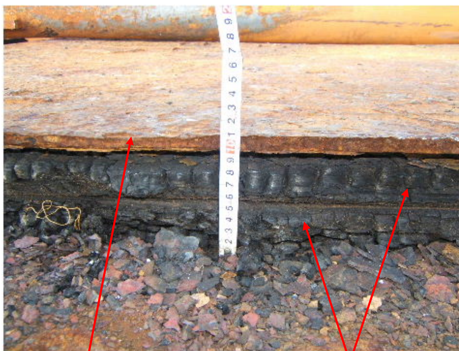
写真11 クレーン車走行用鉄板通路の状況②
