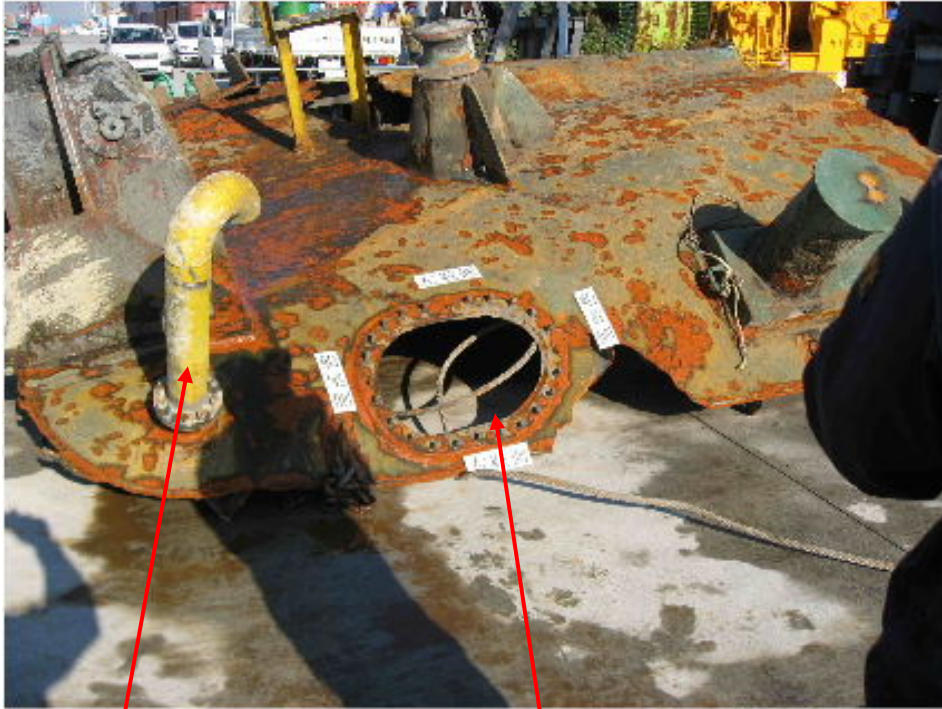
写真7 空気抜き管の状況
