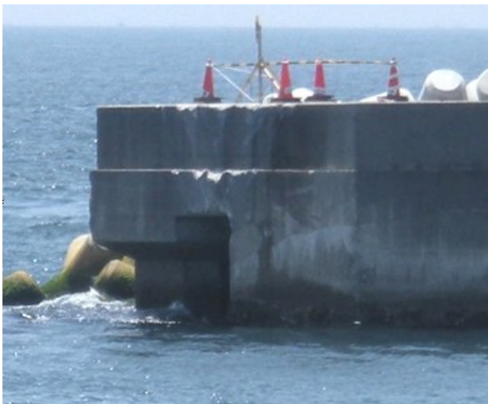
写真2 明石港の西外港南防波堤東端の損傷
