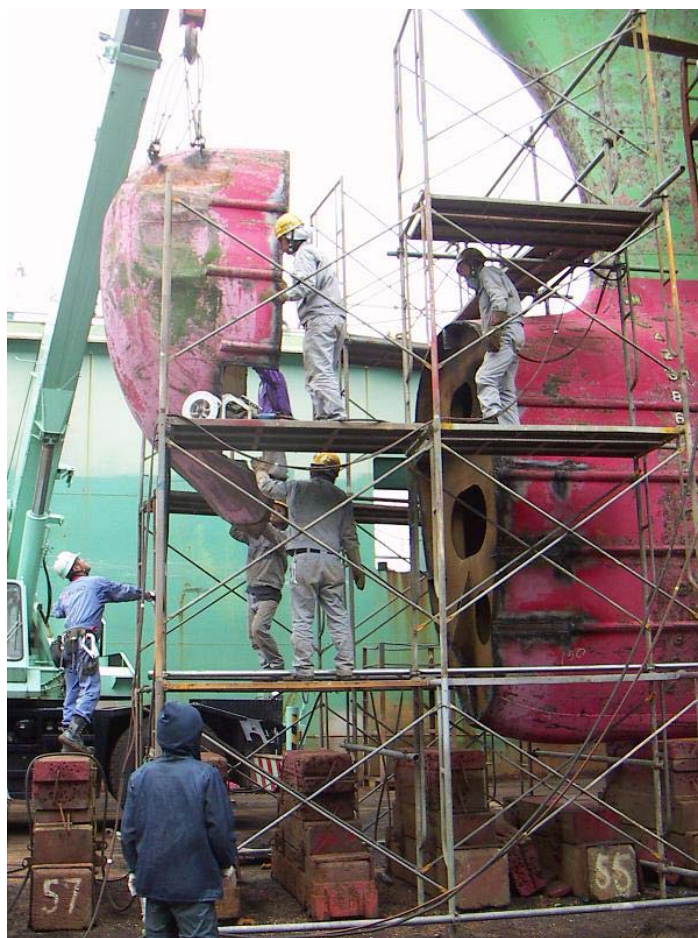
写真1 球状船首の本修理時の状況
