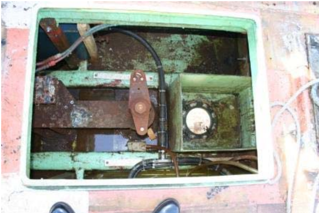
写真6 舵機室の状況
