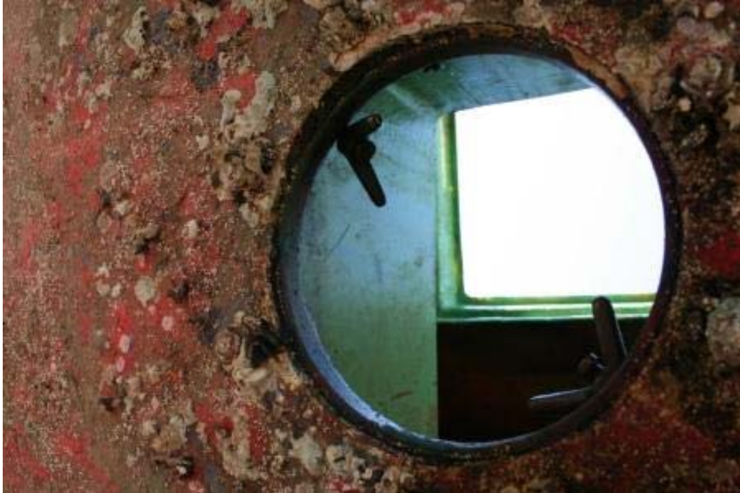
写真3 プロペラ点検口の状況
