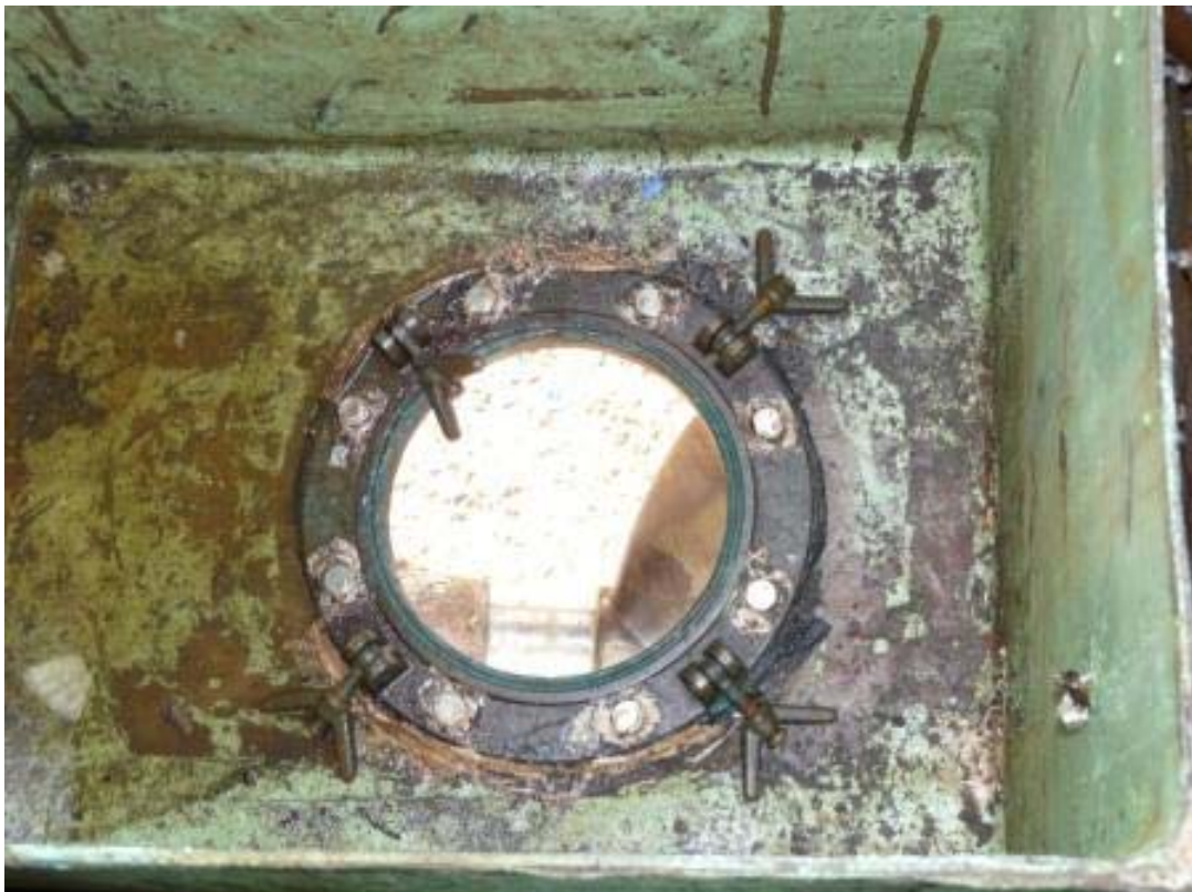
写真4 プロペラ点検口の状況
