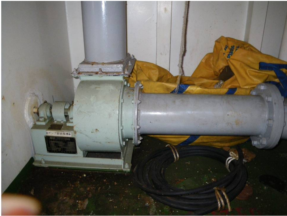
写真4 ポンプ室周辺
