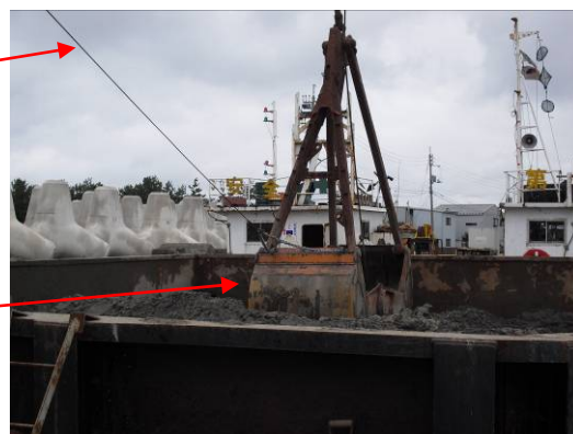
写真2 バケットと振れ止めワイヤー
