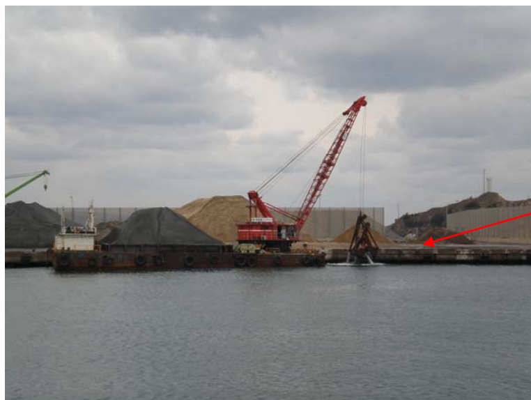
写真1 事故発生場所において浚渫作業中の本件台船
