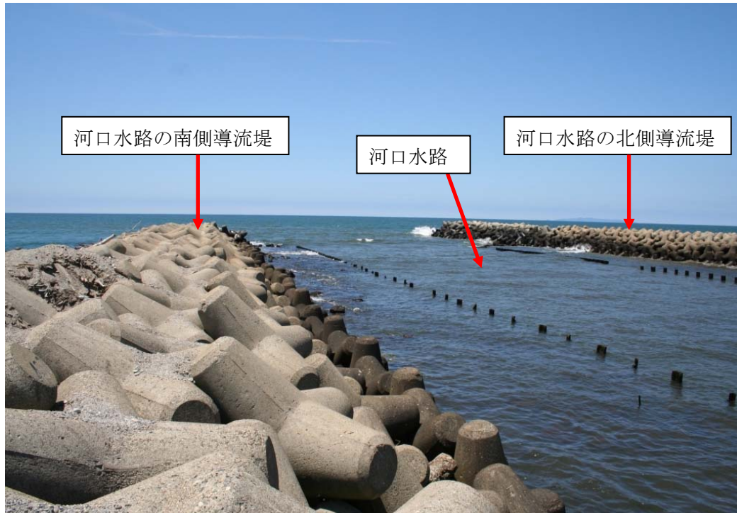
写真5 河口水路の状況
