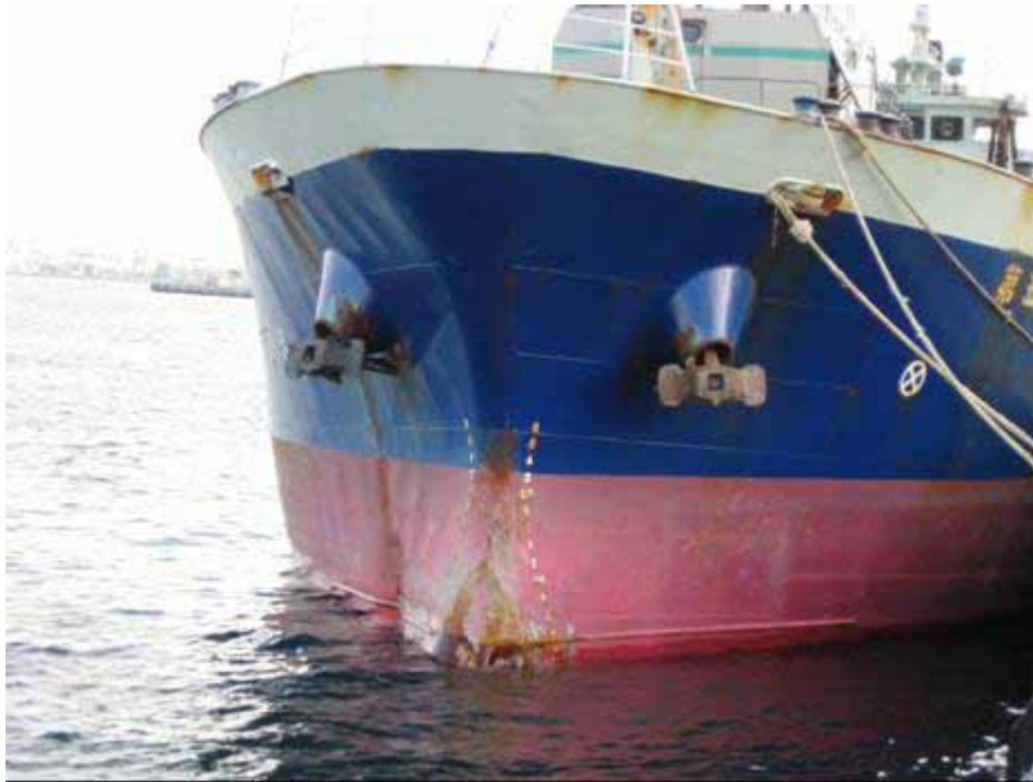
写真1 船首部分の状況
