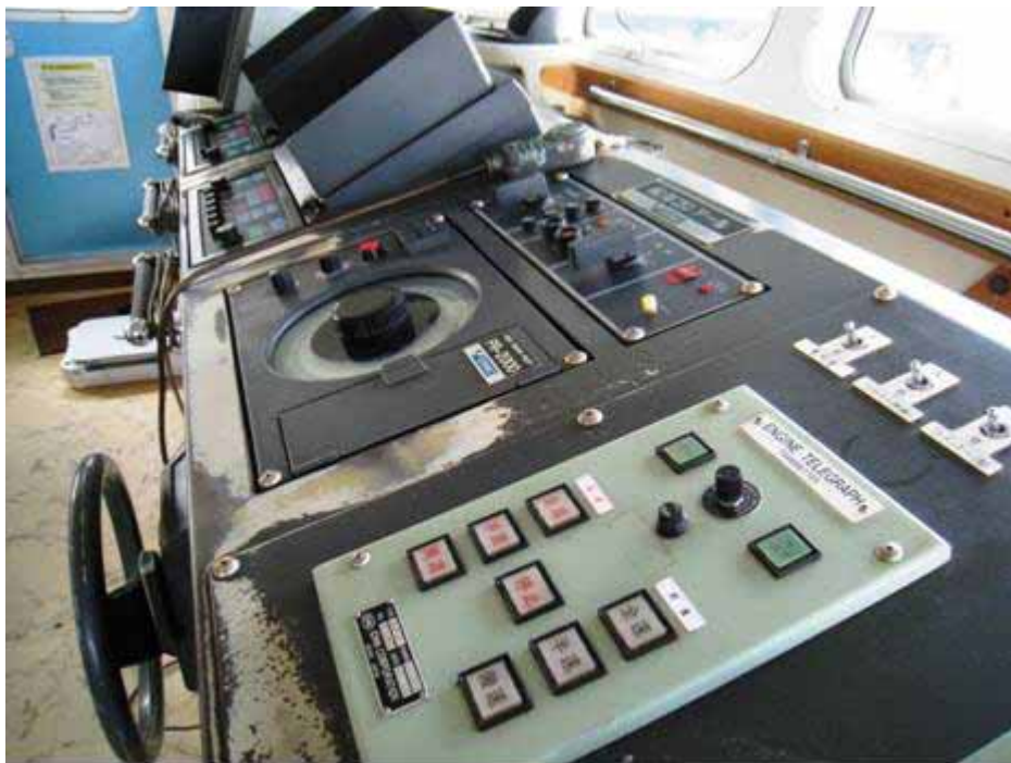
写真2 操舵コンソール
