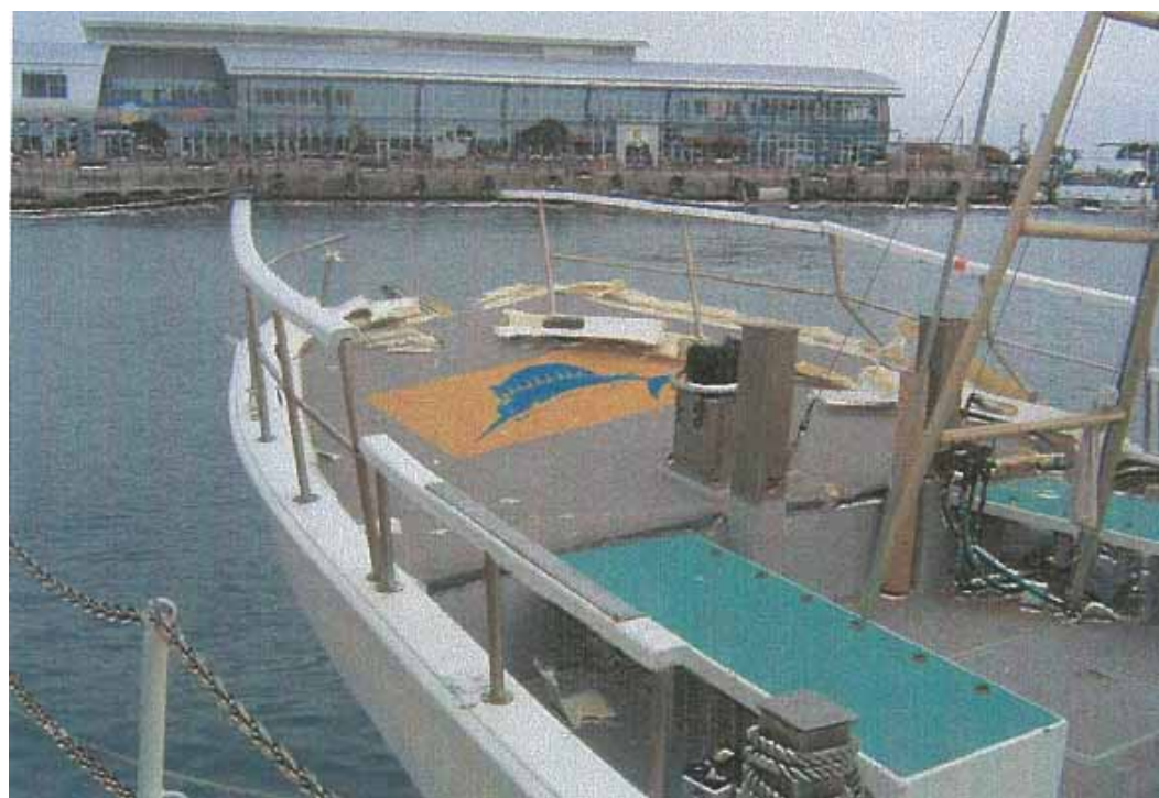
写真4 B船のハンドレール欠落
