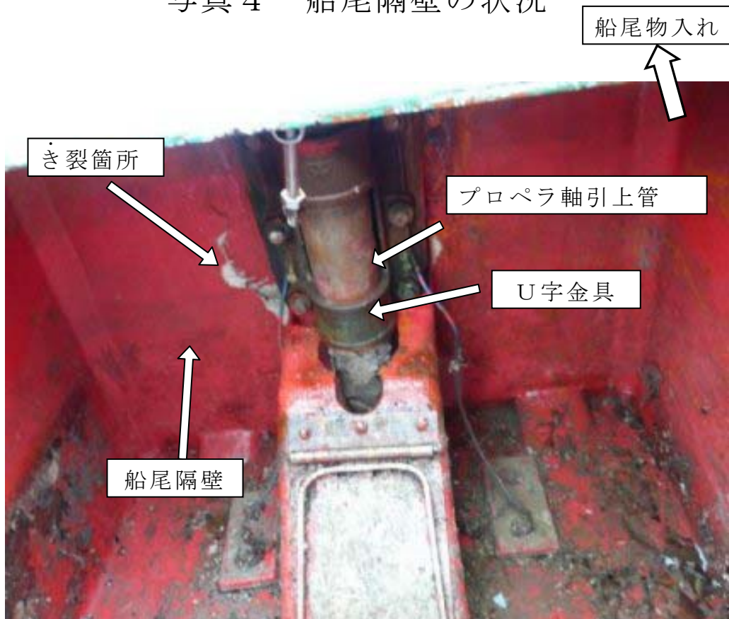
写真4 船尾隔壁の状況
