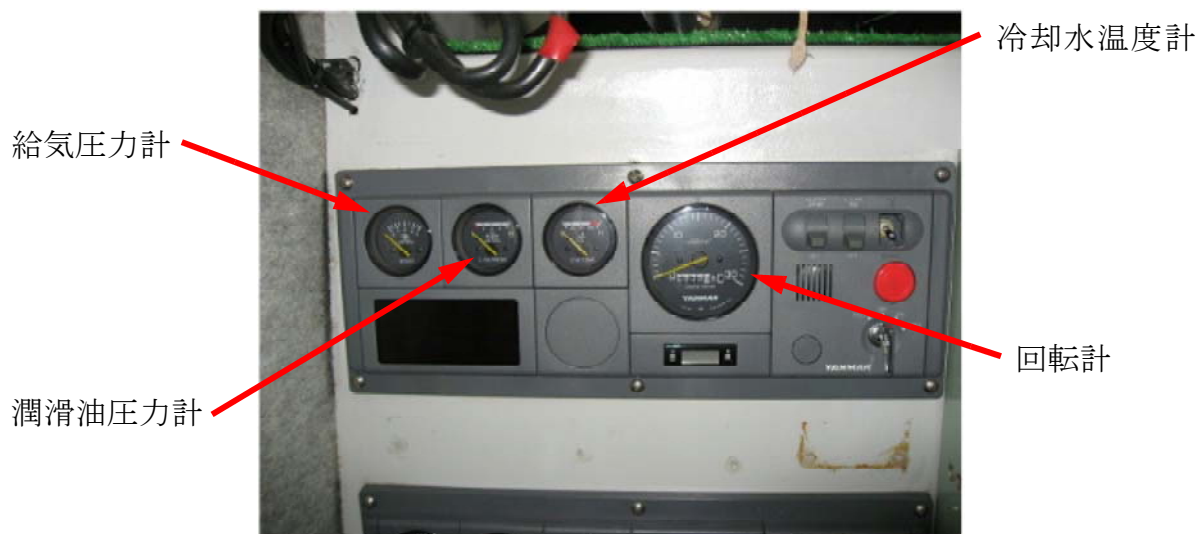
写真4 主機計器盤の状況
