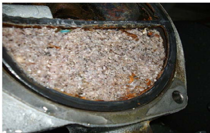
写真9 清水冷却器の冷却管閉塞状況 (外蓋取外し直後の写真)
