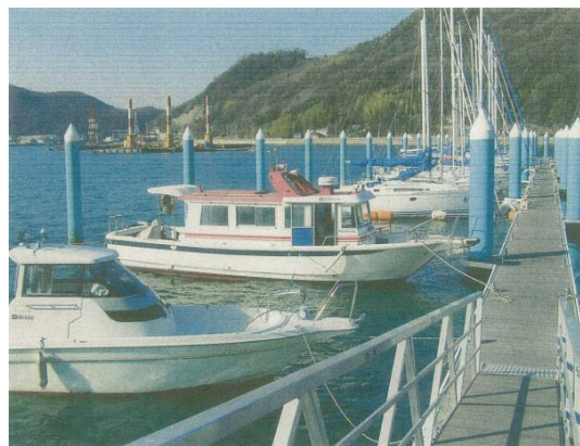
平成17年2月撮影(事故前)
