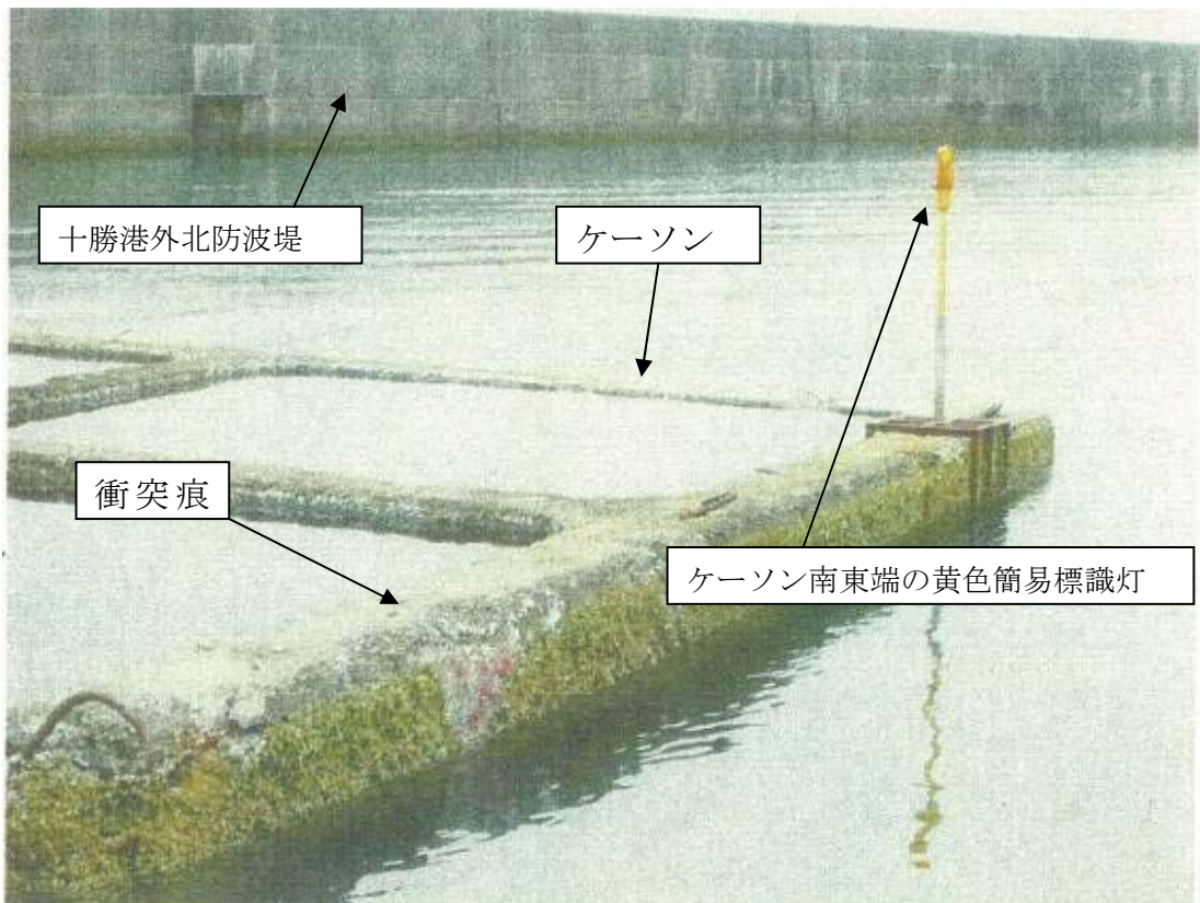
写真4 ケーソン南東端付近
