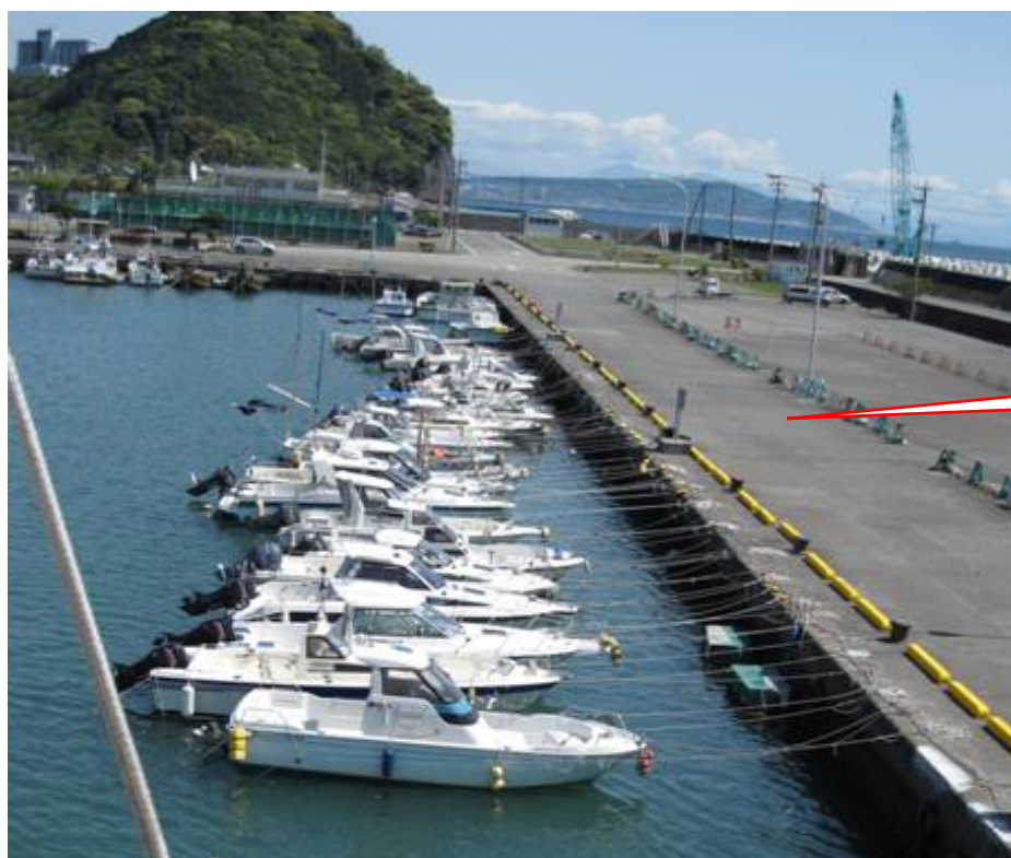
写真1 6号岸壁のボート係留状況
