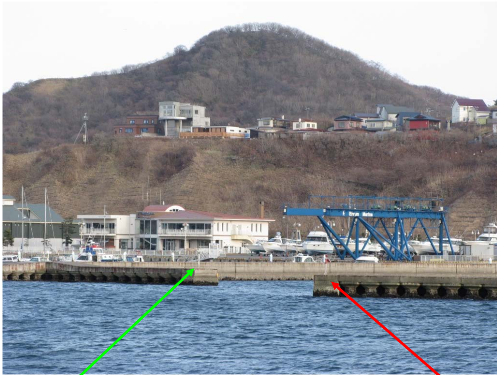
(外側西防波堤から南東方を望む)
