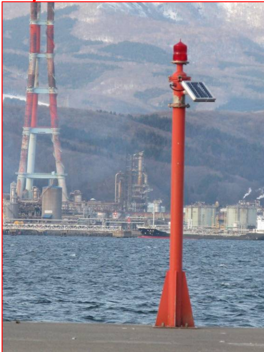
外側西防波堤標識灯（紅灯）
