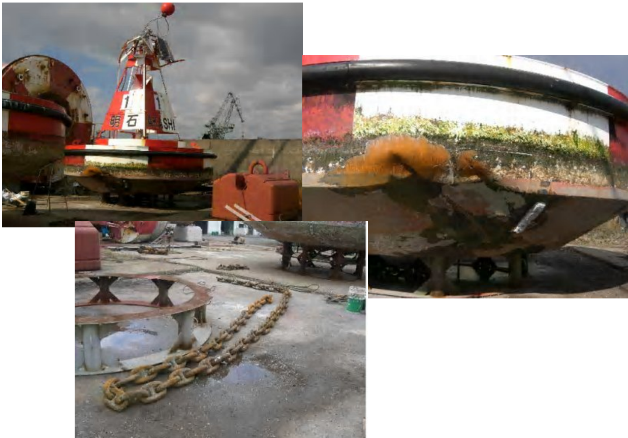
写真6 灯浮標損傷の状況
