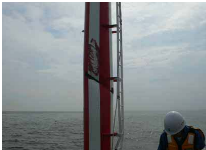
写真3 凹損及び亀裂（拡大）
