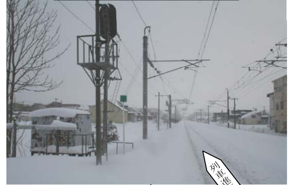
上り2信号機付近からの撮影
