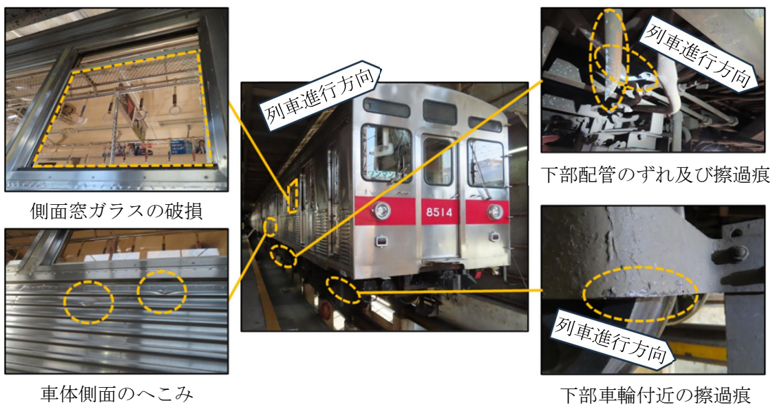
図5-2 車両の損傷状況2 (側面)
