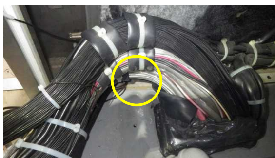
元空気タンク、低圧端子台架台を 外した状態
