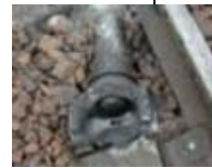
脱落した推進軸(継手) (68k486m付近)
