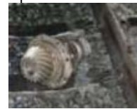
脱落した減速機カサ歯車 (67k020m付近)
