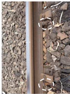
⑥まくらぎNo. -27付近右レール 軌間内側の犬くぎの抜け上がり
