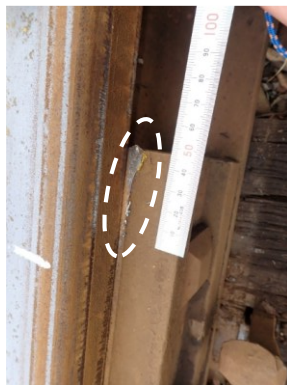
③まくらぎNo. -40付近右継目板 の角の衝撃痕
