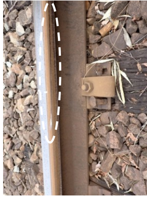
④まくらぎNo. -38付近右レール 軌間内側頭部側面の線状痕
