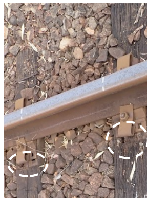
⑦まくらぎNo. -25付近右レール タイプレートのずれ
