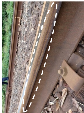
②まくらぎNo. -60付近右レール 軌間内側頭部側面の線状痕
