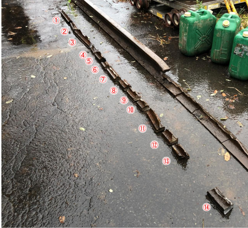
図8 飛散したレール頭部の一部
