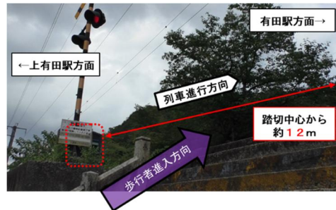
図9 本件歩行者進入側からの列車見通し状況
