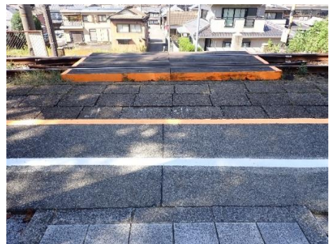
施工後（神社側）
