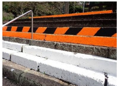
施工後（本件歩行者進入側）
