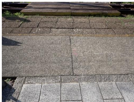
施工前（神社側）
