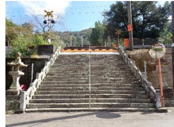
施工後（本件歩行者進入側）
