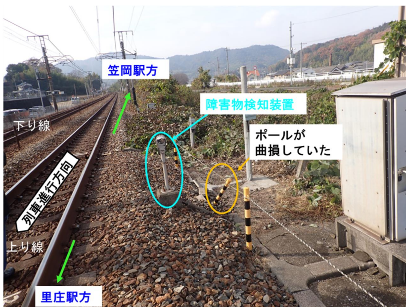
付図4 鉄道施設の損傷
