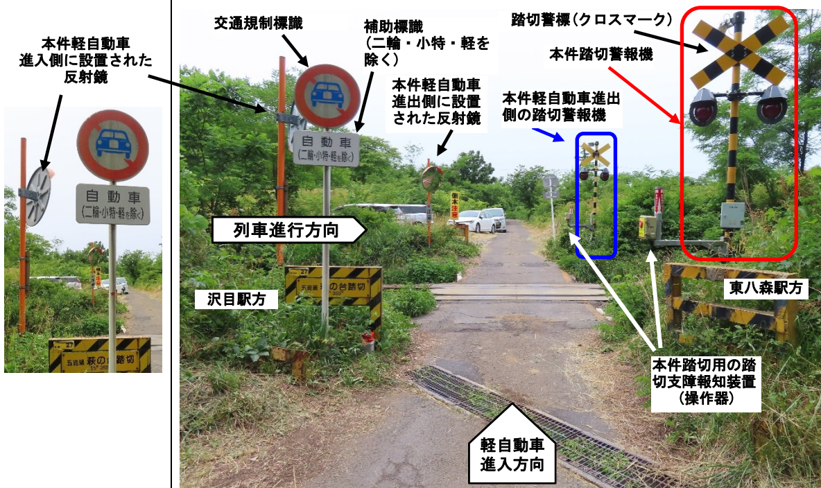
図5 本件踏切の状況
