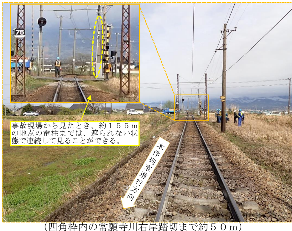
図5 本事故現場付近からの列車進来方向の見通し
