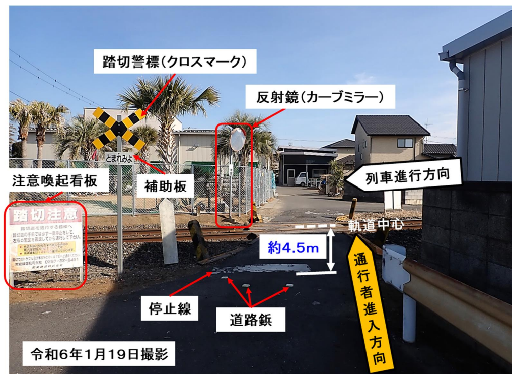
図4 本件通行者進入側から見た本件踏切の状況
