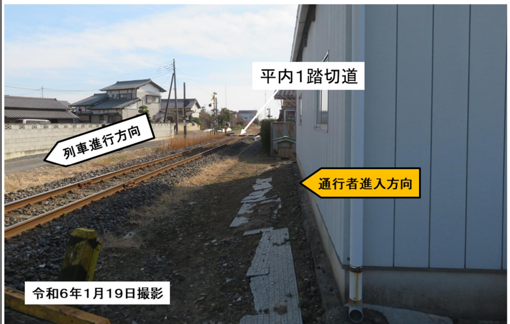
図6 本件通行者進入側から見た下り列車接近方向の見通し状況 (軌道中心線まで約5mの位置)
