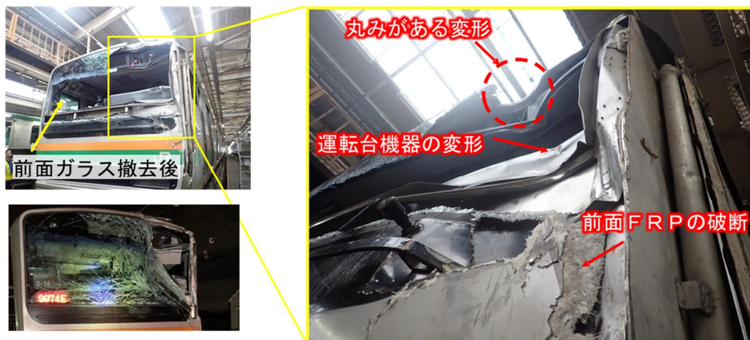
本事故発生直後の前面ガラスの破損状況
