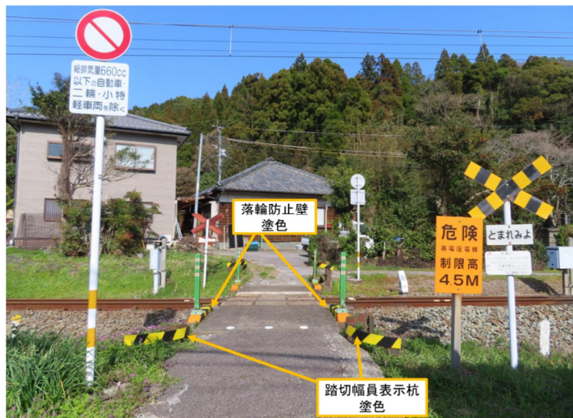
図11 同社による塗色後の本件踏切の状況
