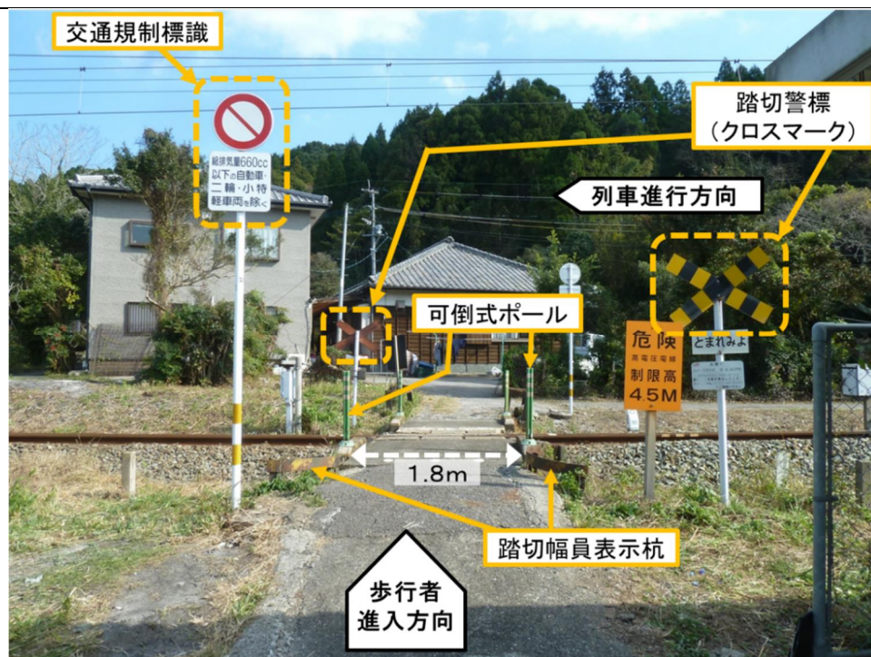
図4 本件歩行者進入側から見た本件踏切の状況
