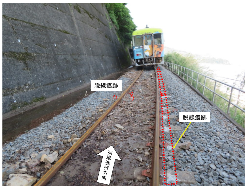
付図 1 6 脱線の痕跡 その 2
