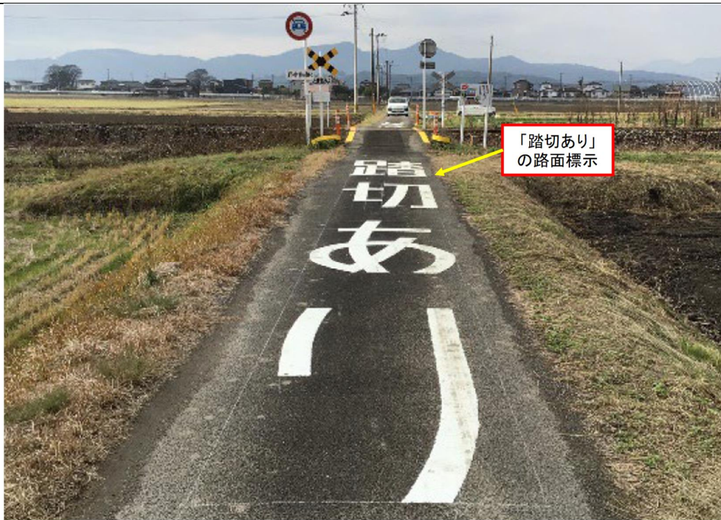
図1-1 同市による路面標示実施後の本件踏切の状況
