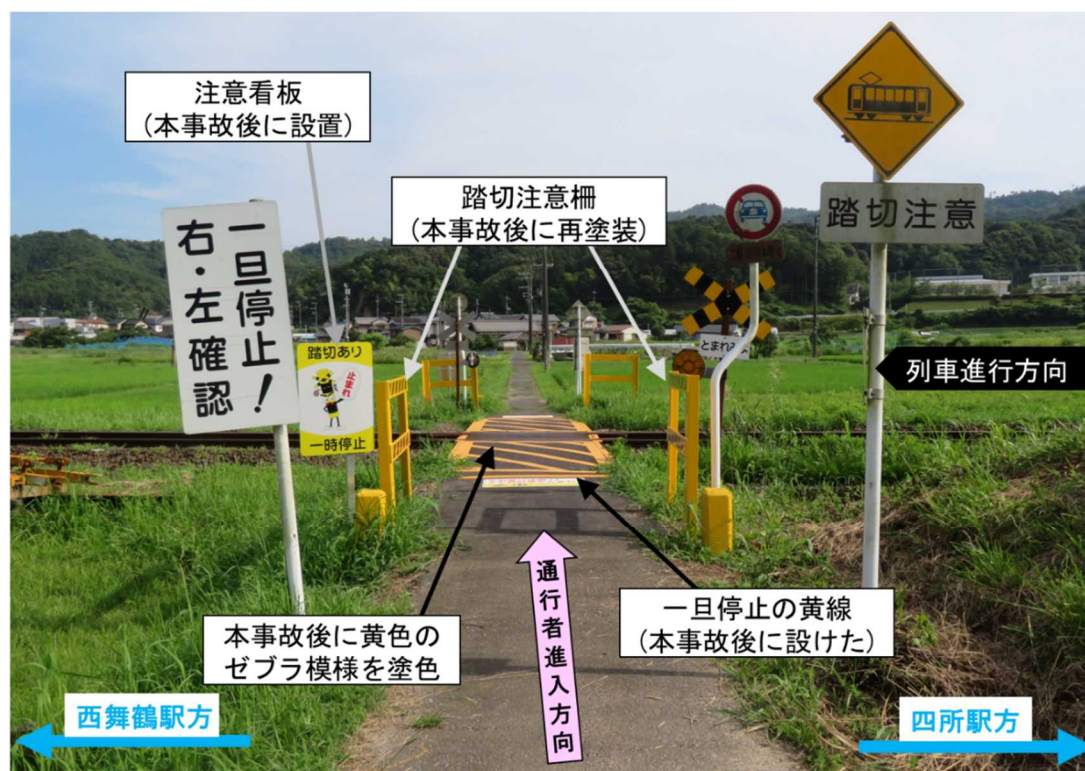
図12 本事故後に講じられた本件踏切の措置
