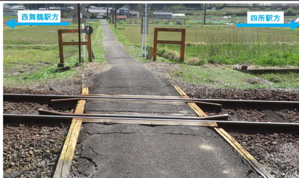
図4 本件踏切内の路面の状況
