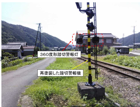
図14 本件踏切警報機の対策状況
