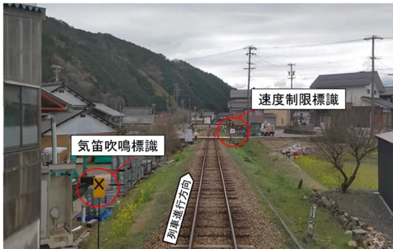
図12 気笛吹鳴標識と速度制限標識
