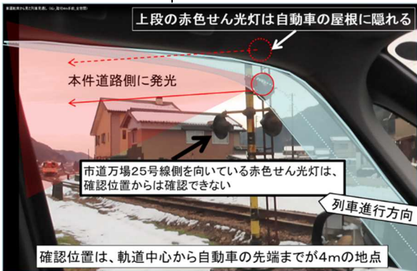
図8 本件踏切警報機の赤色せん光灯の見通し状況
