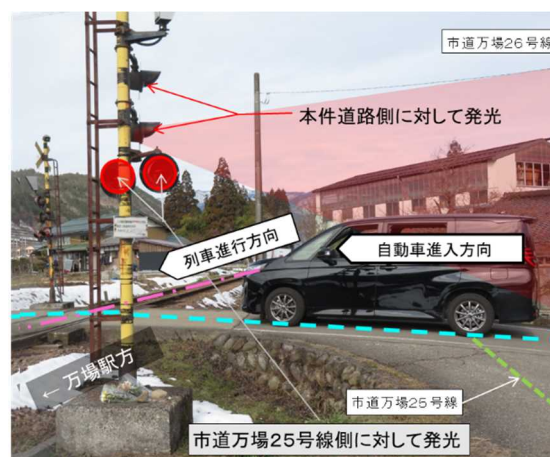
図5 本件踏切警報機の赤色せん光灯の 発光方向
