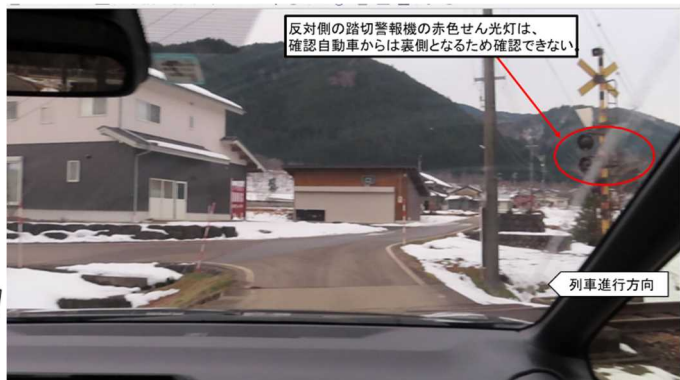
図9 反対側の踏切警報機
