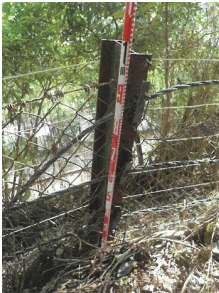
36k174m付近の落石止柵の状況
