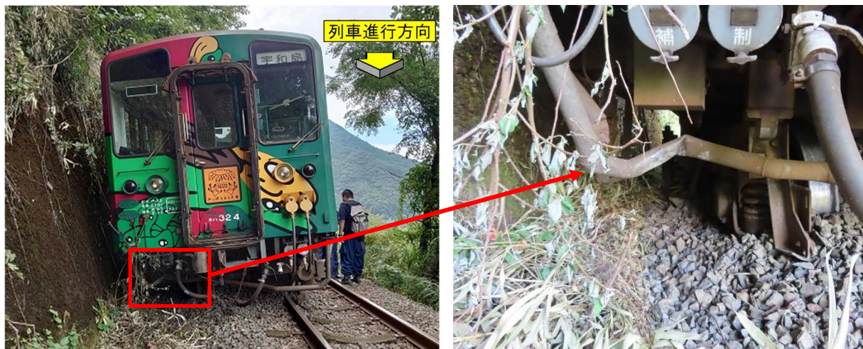
アニマルガードの損傷
