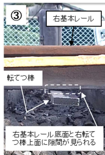
図 1 2 列車が通過していないときの右トングレールと転てつ棒の状態
