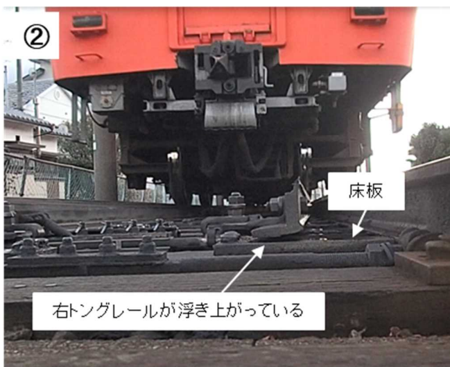
図 1 3 背向で列車が通過するときの右トングレールと転てつ棒の状態
